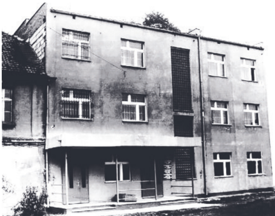
Budynek Urzędu Gminy Baranów, 1990 r.
