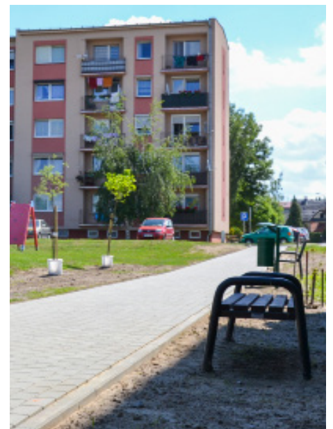
Nowa ścieżka na Osiedlu „Murator”
