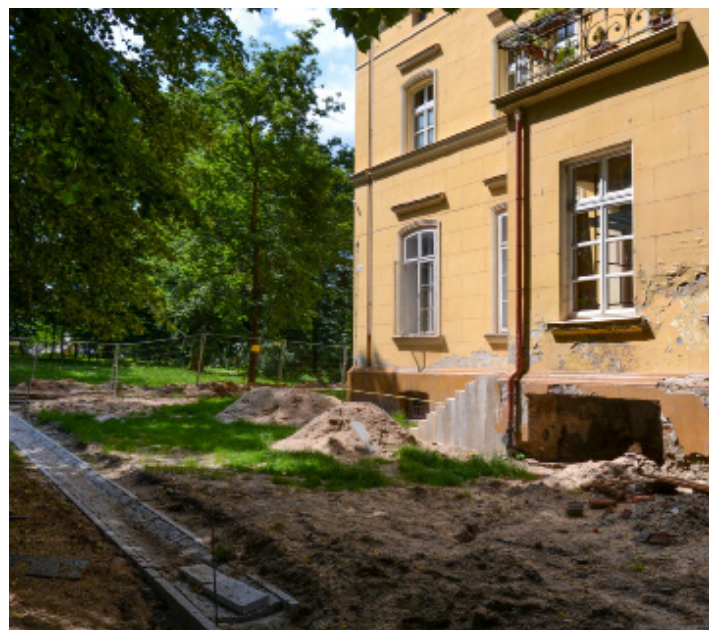
Remont pałacu w Mroczeniu
