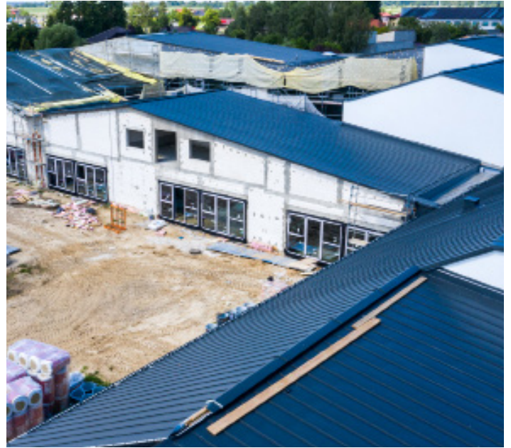
Budowa kompleksu sportowo-oświatowego w Baranowie
