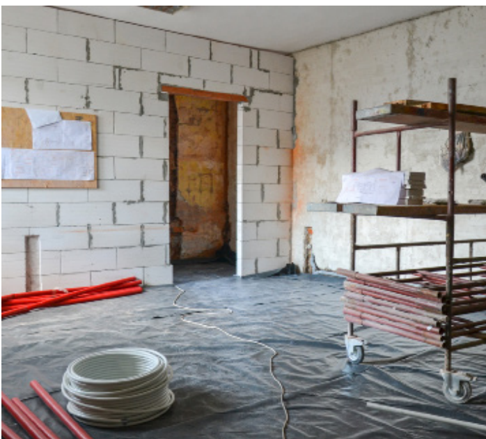
Remont kuchni Domu Ludowego w Słupi pod Kępem
