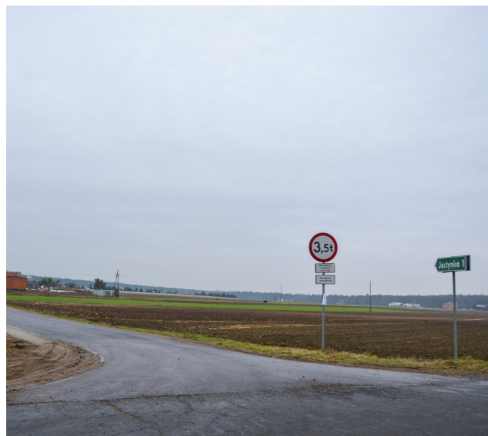
Nowa droga w Justynce
