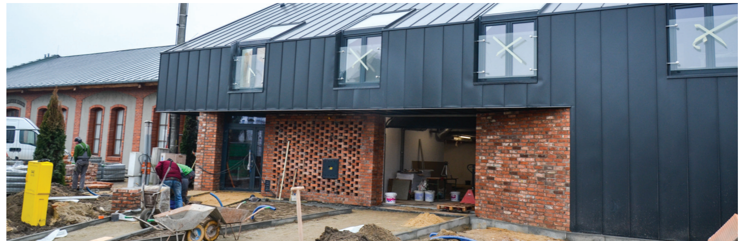
Budowa nowej części Baranowskiej Chaty
