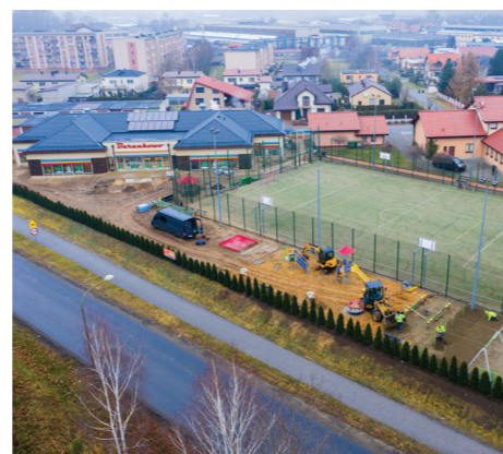
Remont placu zabaw przy Barankowie
