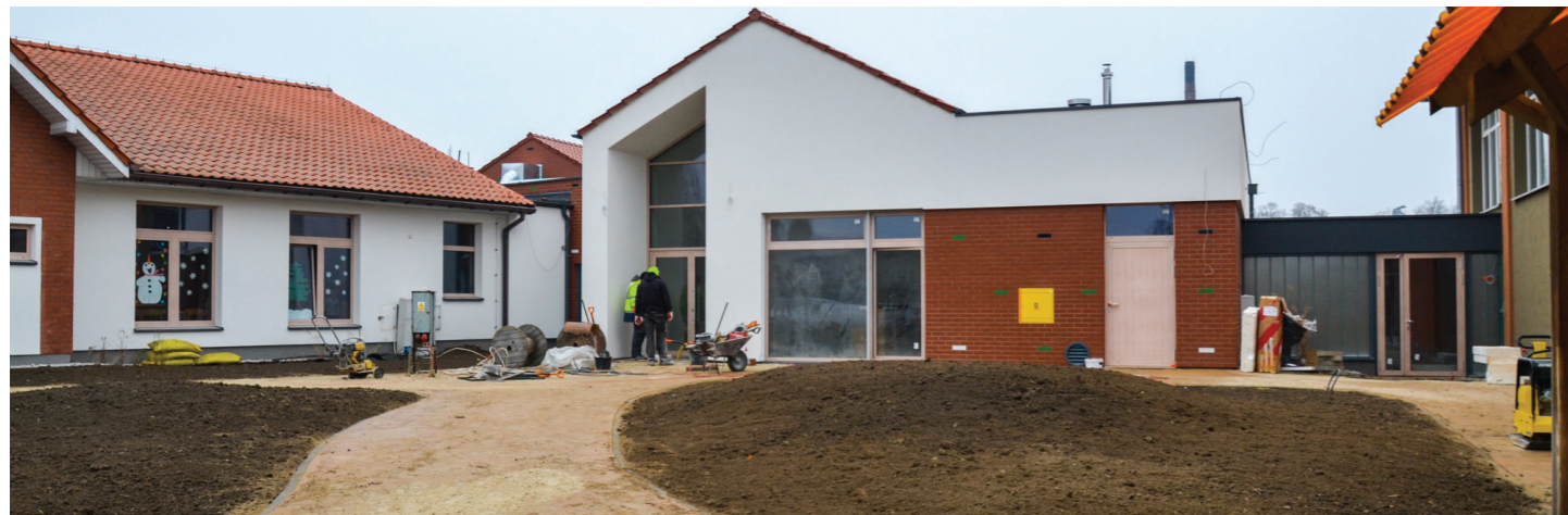
Kończą się prace przy budowie oddziału przedszkolnego w Słupi pod Kępem
