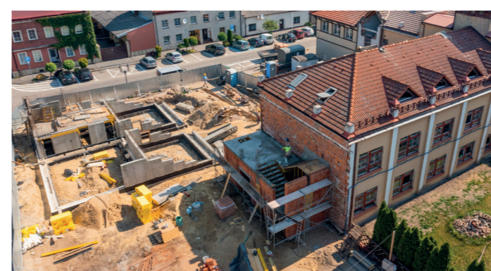
Nowa klatka schodowa już rośnie
