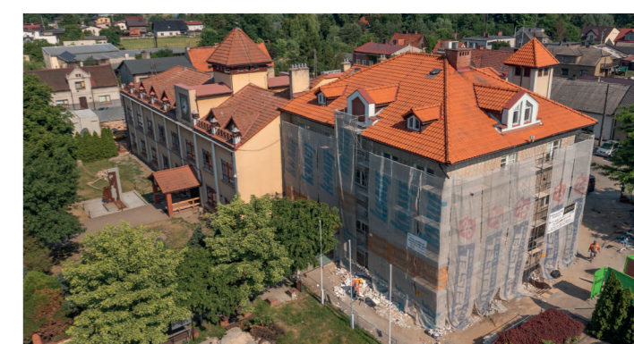
Przystąpiono do wymiany elewacji
