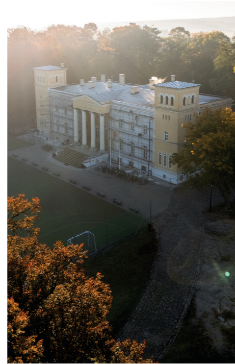
Remont Pałacu w Mroczeniu
