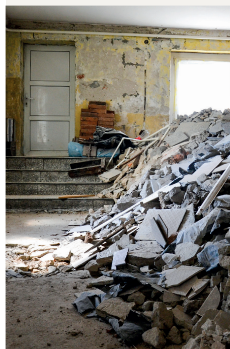
Kuchenne remonty w Słupi pod Kępnem (kwiecień 2020 r.)
