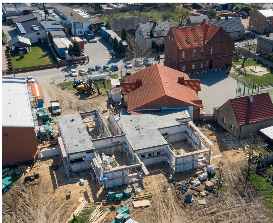
Budowa Przszkola w Słupi pod Kępnem (kwiecień 2020 r.)
