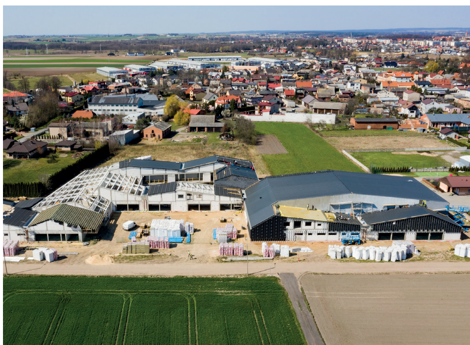
Budowa kompleksu oświatowo-sportowego w Baranowie (kwiecień 2020 r.)
