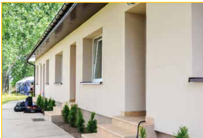
Szatnia w Jankowach została wyremontowana
