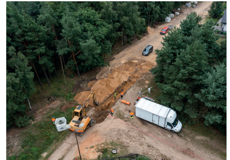
Na Muratorze trwają prace ziemne przed położeniem nowego asfaltu
