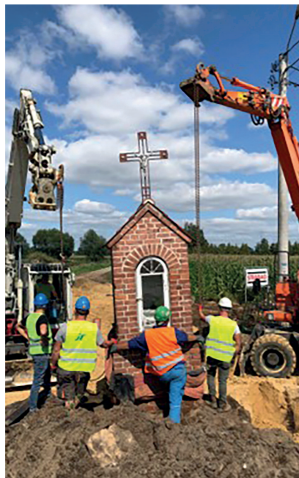
Latem 2021 roku, w trakcie budowy obwodnicy Baranowa, naszą kapliczkę przesunięto o kilka metrów. Jednak ocalała
